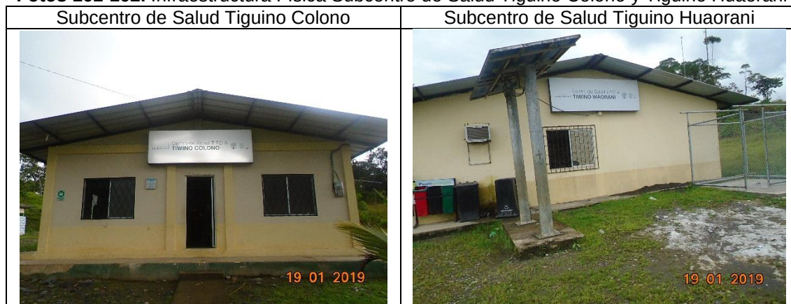
Fotos 161-162. Infraestructura Física Subcentro de Salud Tiguino Colono y Tiguino Huaorani
